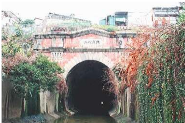
湊川隧道（会下山トンネル）
